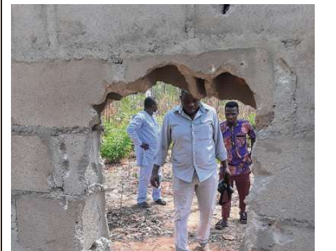
Durch die Mauer. Die Angreifer sprengten sich den Weg frei. Foto: Reuters
